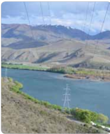
Obr. 1 Přenosové vedení společnosti Transpower, Benmore, Nový Zéland
