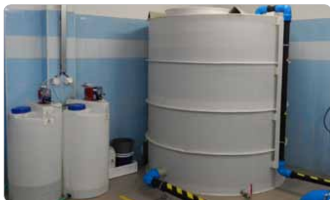
Obr. 4 Koagulant sa dávkuje do vody zo samostatných nádrží, ktoré majú na vrchu umiestnené dávkovacie čerpadlá (na obr. dve nižšie nádrže vľavo)
