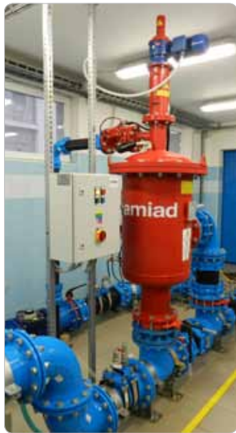
Obr. 3 Prvý filtračný stupeň – sitový filter
