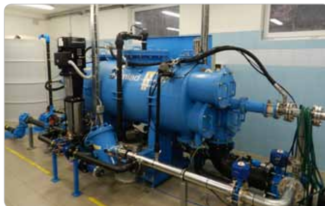
Obr. 5 Hlavný filtračný stupeň
