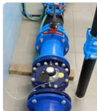
Obr. 2 Fakturačné meranie prietoku na vstupe úpravne
