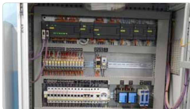
Obr. 1a Pohľad do rozvádzača s riadiacim systémom Simatic S7-200
